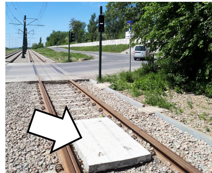
Sygnalizacja świetlna wzbudzana – sygnalizator wzbudzenia i detektor indukcyjny
